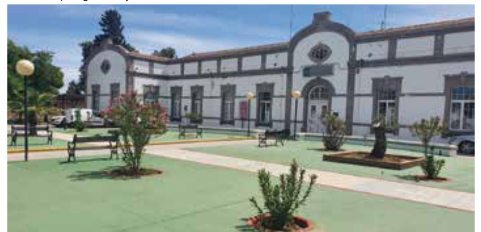
Vista de los exteriores del Centro de Salud tras la reforma
