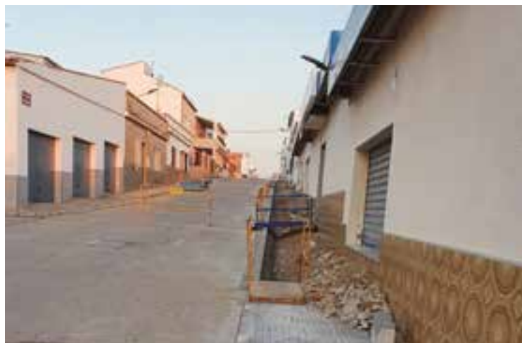
Trabajos de mejora en la calle Colombia
